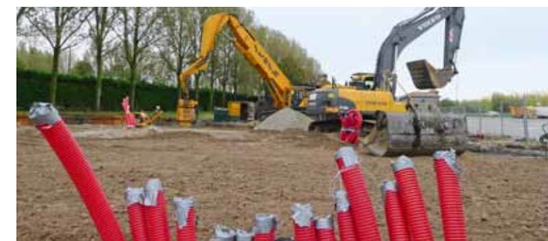
• BSP Moerdijk in aanbouw
