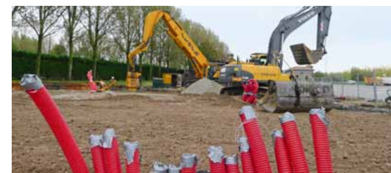
• BSP Moerdijk in aanbouw
